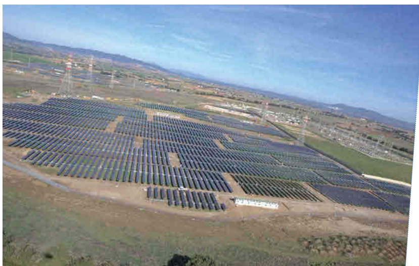
Sunray Montalto di Castro photovoltaic, Italy
