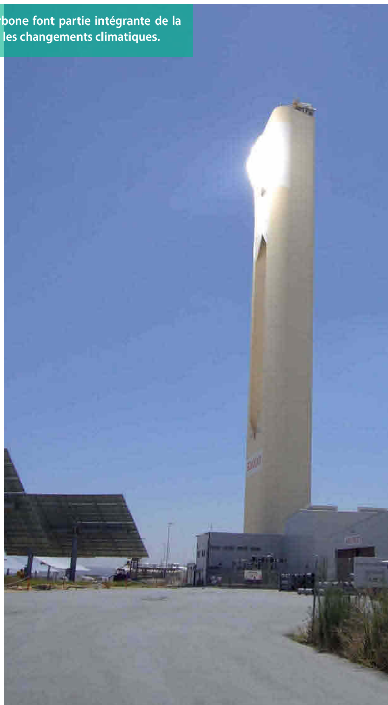
Tour solaire, projet Solucar, Espagne
