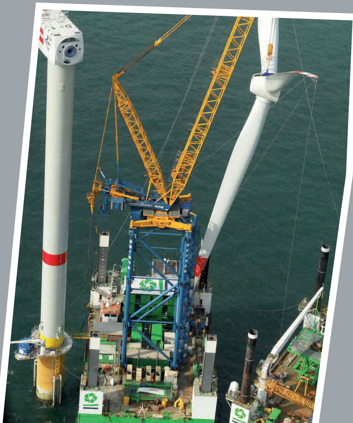
Érection d'une éolienne en mer au large de la Belgique
