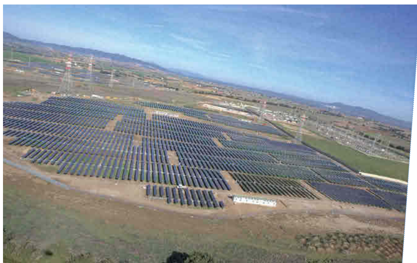
Installations photovoltaïques de SunRay à Montalto di Castro, Italie
