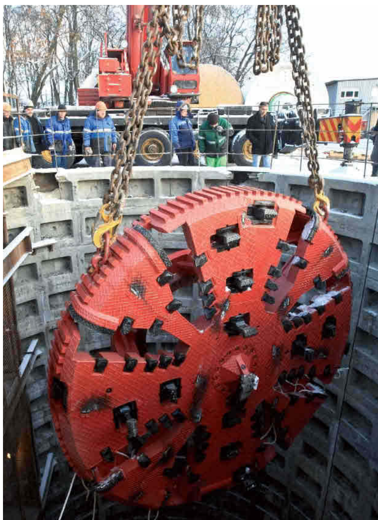
Construction du collecteur principal, Saint-Petersbourg, Russie
